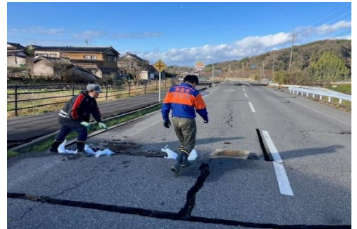
輪島市消防団による亀裂の入った道路補修の様子 (輪島市消防団門前分団員提供)
