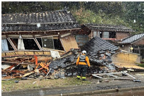
珠洲市正院町家屋倒壊現場
