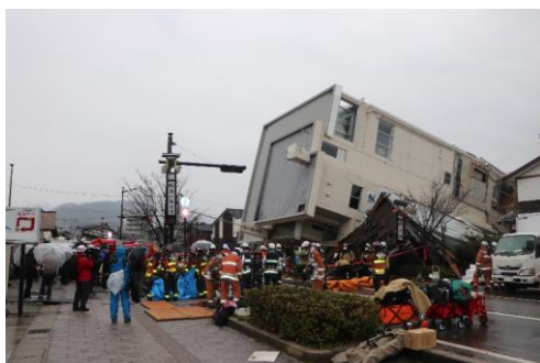
輪島市河井町建物倒壊現場（大阪市消防局提供）
